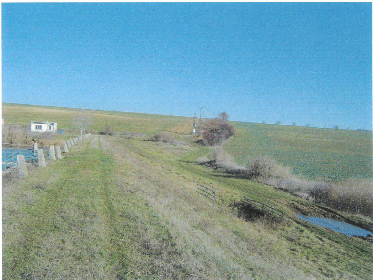
hrádza vodnej nádrže na Kvetnianke
